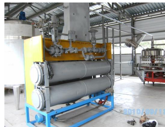
Подача сока на узел розлива
