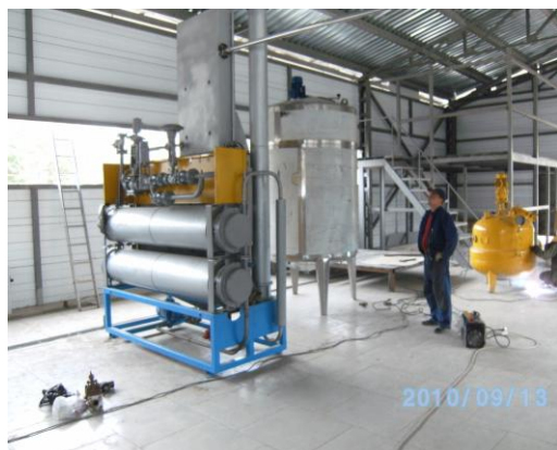
В процессе монтажа
